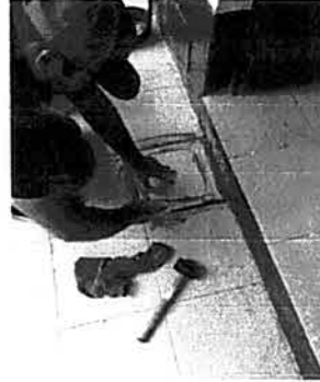
Foto 2: Reparación de piso cerámico.
