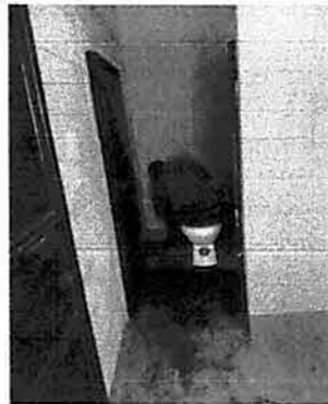
Foto 2: Reparación de letrinas.
