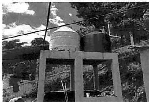
Foto 6: Reposición de Tuberia de Agua en mal estado
